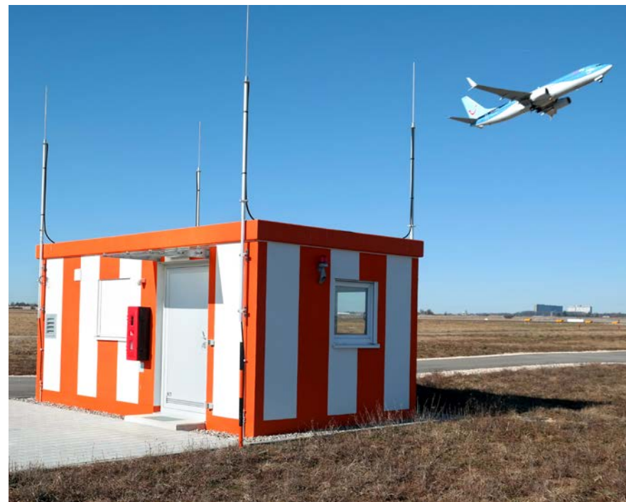
Fertigteilgebäude mit äußerem und innerem Blitzschutzsystem Prefabricated building with exterior and internal lightning protection system
