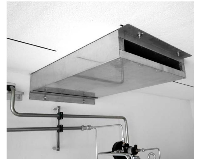
Schallgedämmter Blechkanal Sound-insulated sheet metal duct
