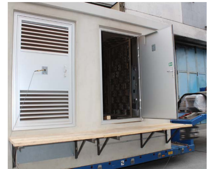
Störlichtbogenprüfung einer begehbaren Station mit IAC-A 20 kA 1s (Bedienerschutz)
