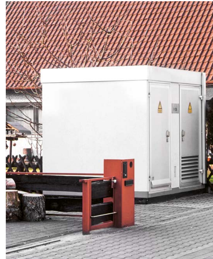
Akustikmessung an einer Netzstation in einem Wohngebiet
