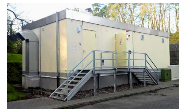
Kombinationsgebäude mit Zwangsentlüftungssystem Combination building with forced ventilation
