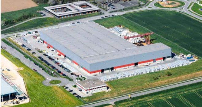
Standort Kösching Location Kösching
