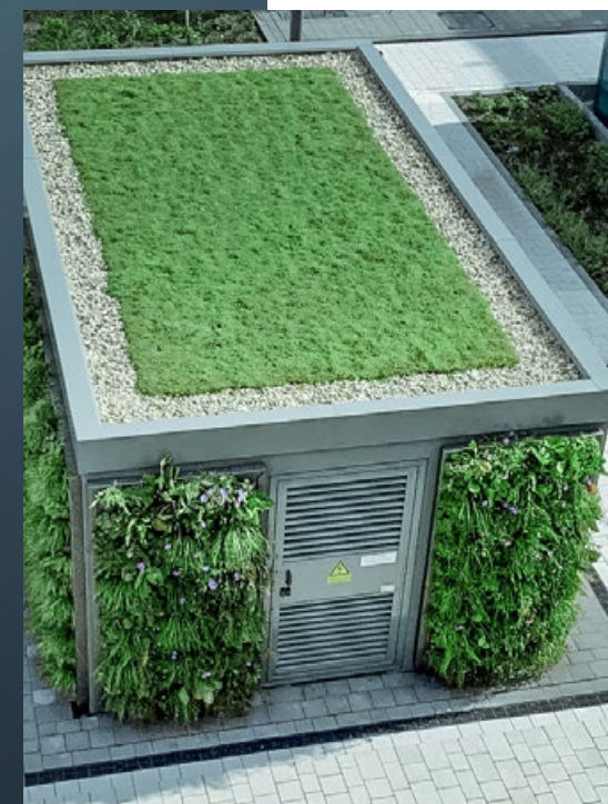
Die erste Trafostation aus Carbonbeton.
