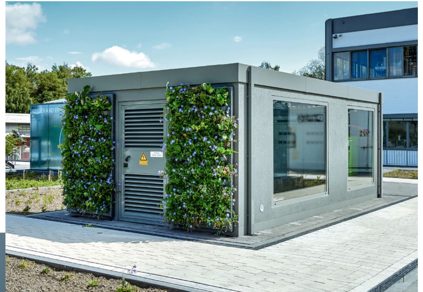
Die erste Trafostation aus Carbonbeton.
