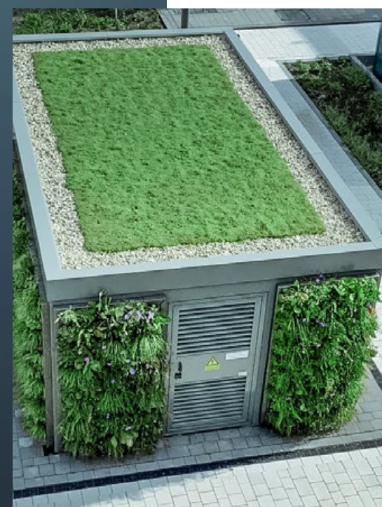
Die erste Trafostation aus Carbonbeton.
