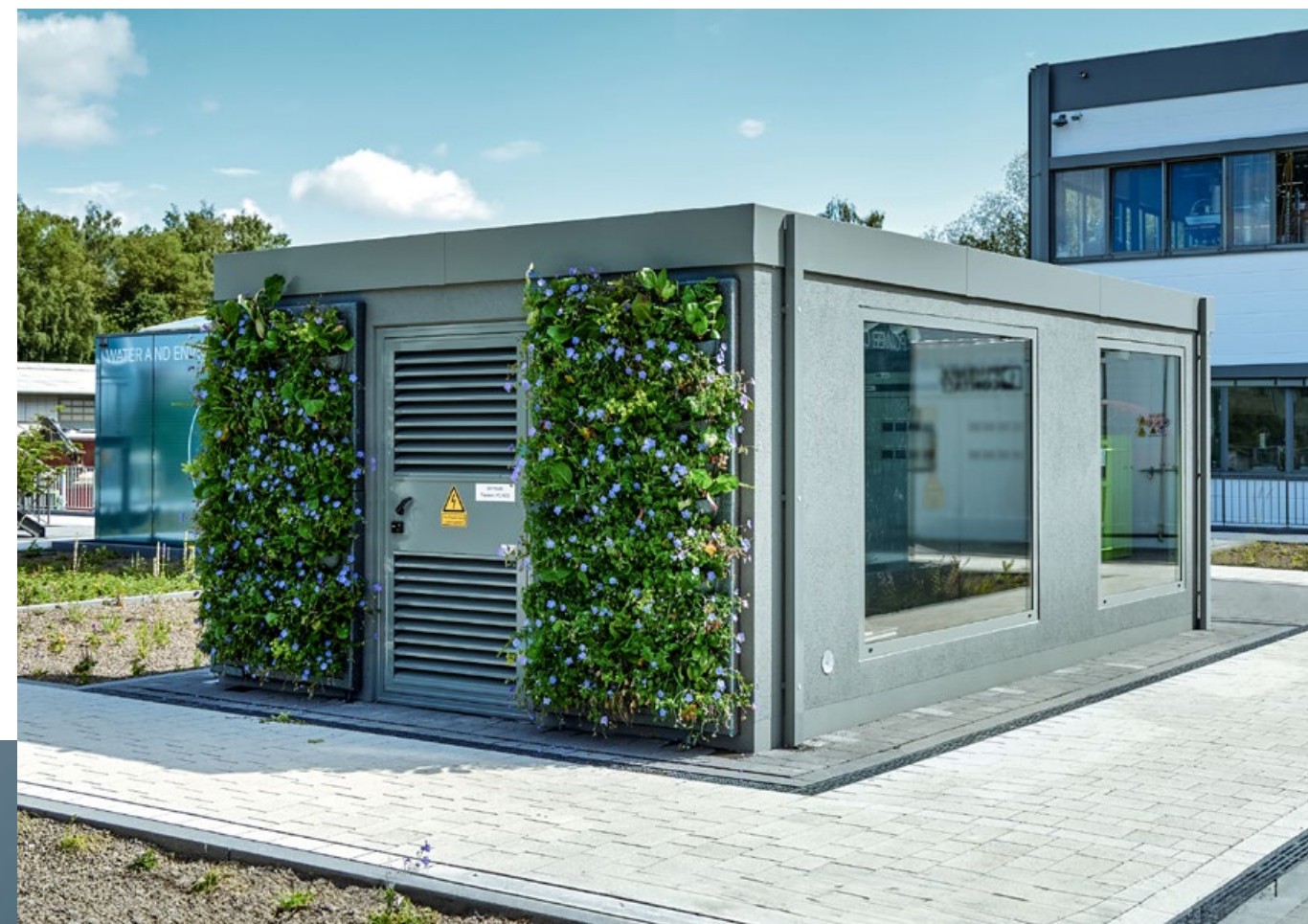
Die erste Trafostation aus Carbonbeton.
