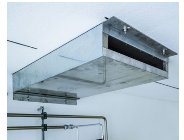
Schallgedämmter Blechkanal
