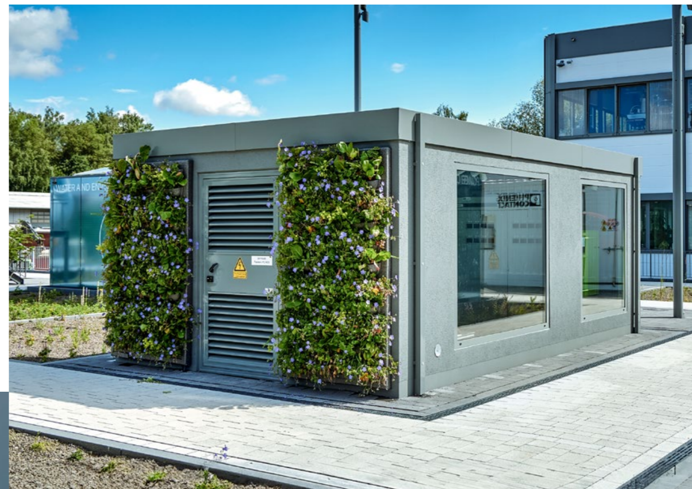
Die erste Trafostation aus Carbonbeton.
