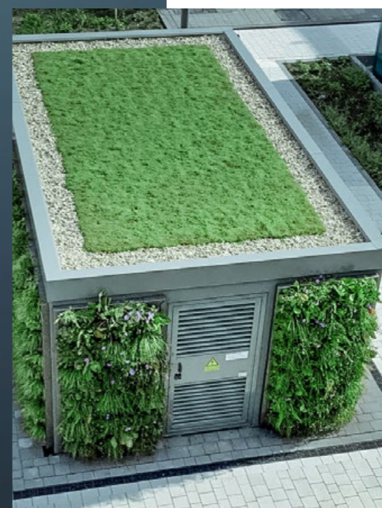
Die erste Trafostation aus Carbonbeton.
