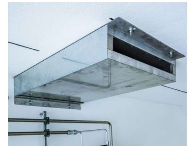
Schallgedämmter Blechkanal
