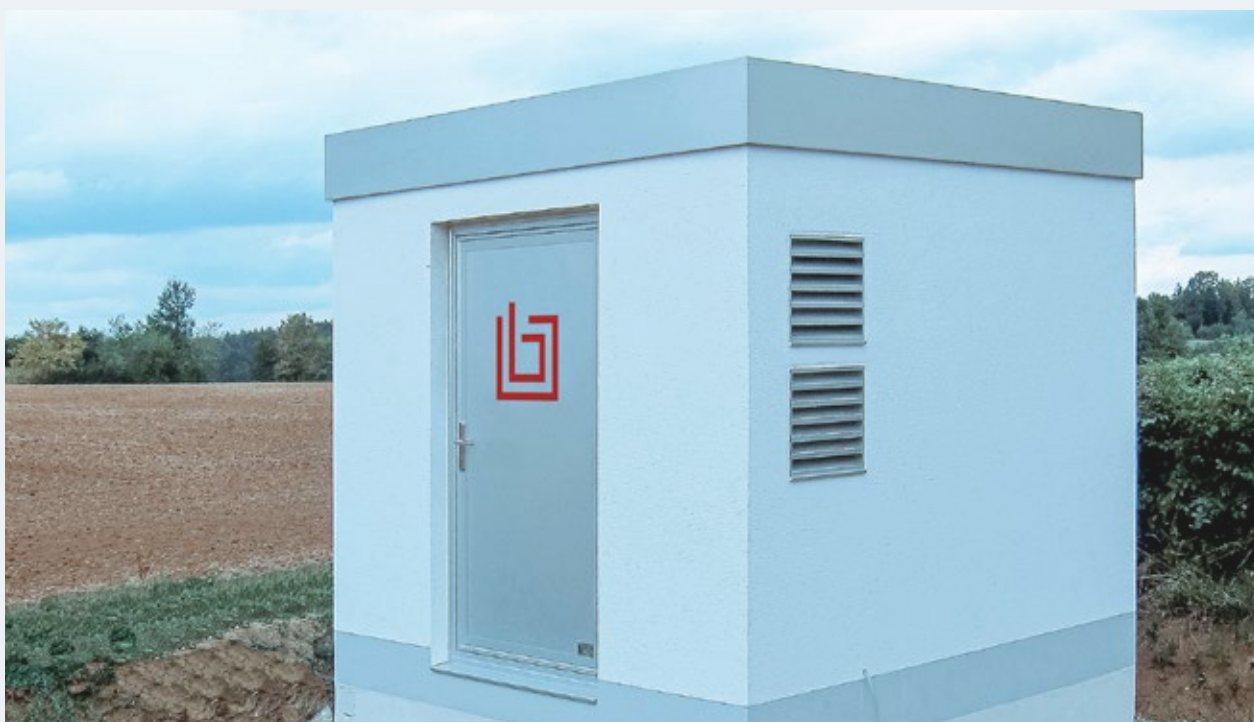
INSTALACE DVEŘÍ A VĚTRACÍCH PRVKŮ
