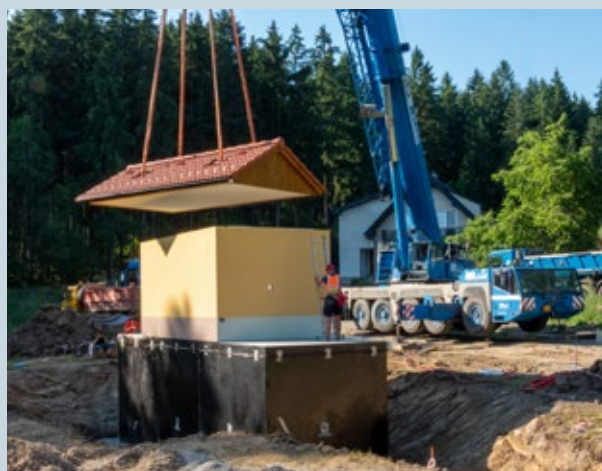
10. Montáž prefabrikované střechy
