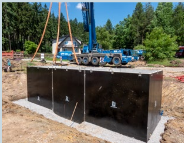
6. Uložení druhé akumulční nádrže
