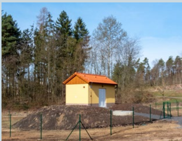
11. Stavba po kolaudaci
