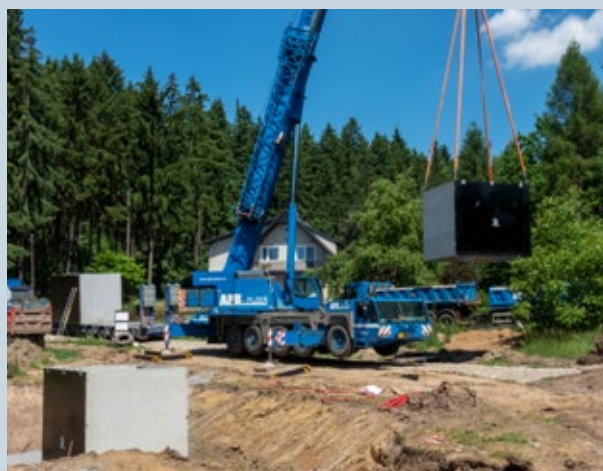
4. Ukládání první akumulční nádrže
