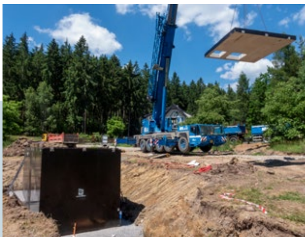
7. Montáž krycích desek
