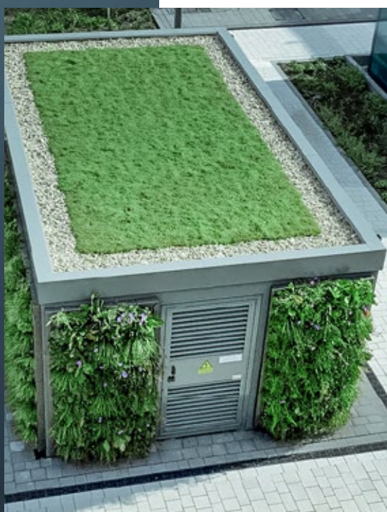
Pierwsza stacja transformatorowa z betonu węglowego.
