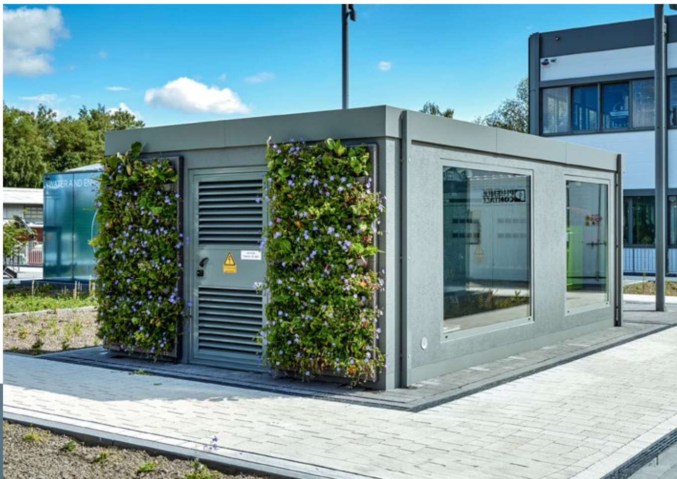
Az első szénbetonból készült transzformátor állomás.
